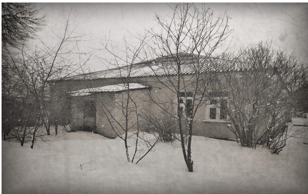
г. Кораблино, ул. Садова, д. 2
